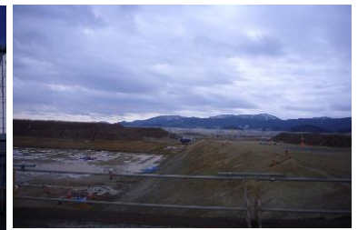
◆かさ上げ工事が続く陸前高田市内の様子◆
