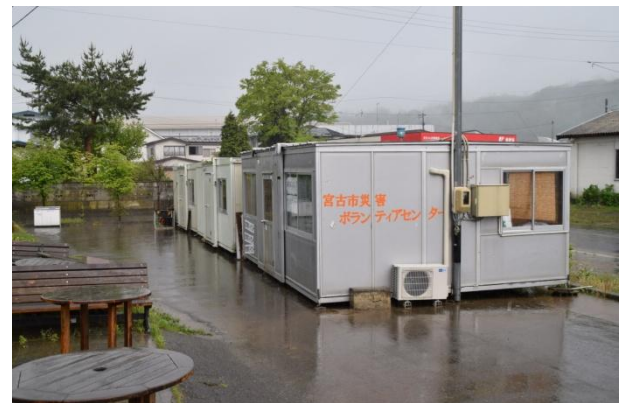
ボランティアセンター開設時に使用していた仮設の事務所。災害に備え、今でも使える状態に保たれています。
