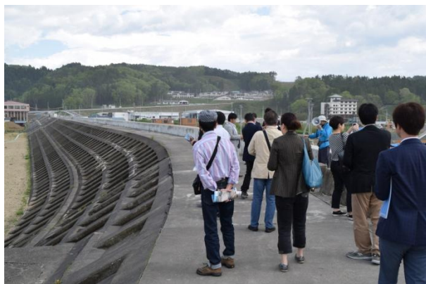
復興が進む田老地区。この防潮堤を越えて津波は街を襲いました。これよりも高い防潮堤が建設中でした。
