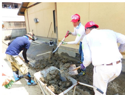
泥を一輪車に積み、運び出す
