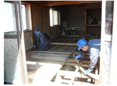
浸水した民家の床板はがしを行う
