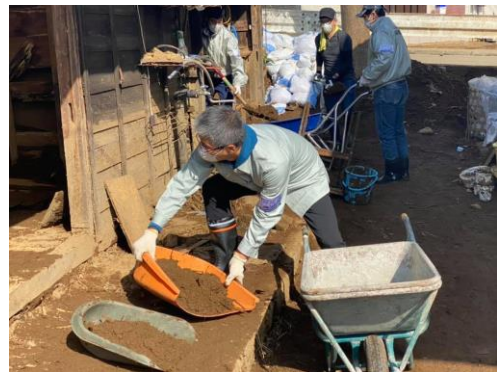
↑泥出し作業等を行っています
