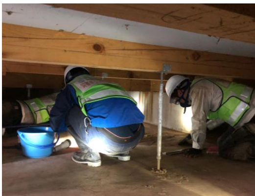
↑中腰での床下の泥かき作業は重労働です
