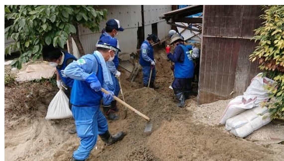
▲建物の間に堆積した土砂の撤去作業
