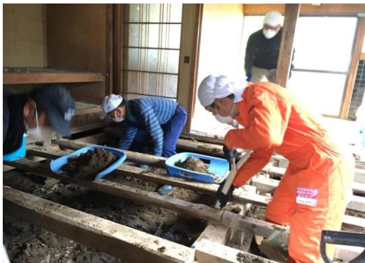
▲畳と床板を剥がした後、土砂を取り除く様子
