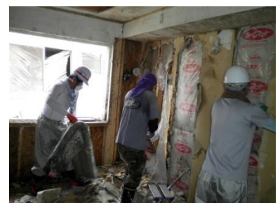
■バールを使って壁の建材を撤去 （25日・石巻）
