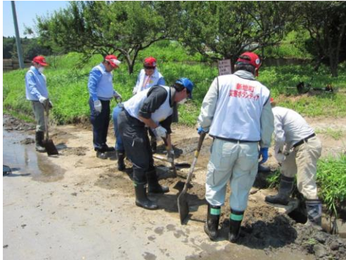
■新地町での側溝清掃（11日）
