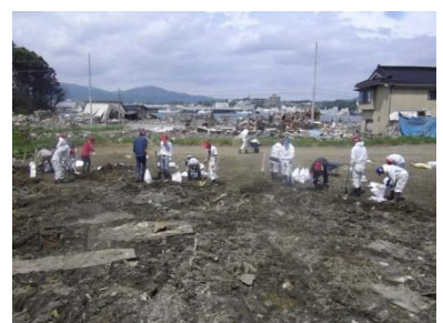
■水田に堆積した土砂を撤去する。 （22日・気仙沼）
